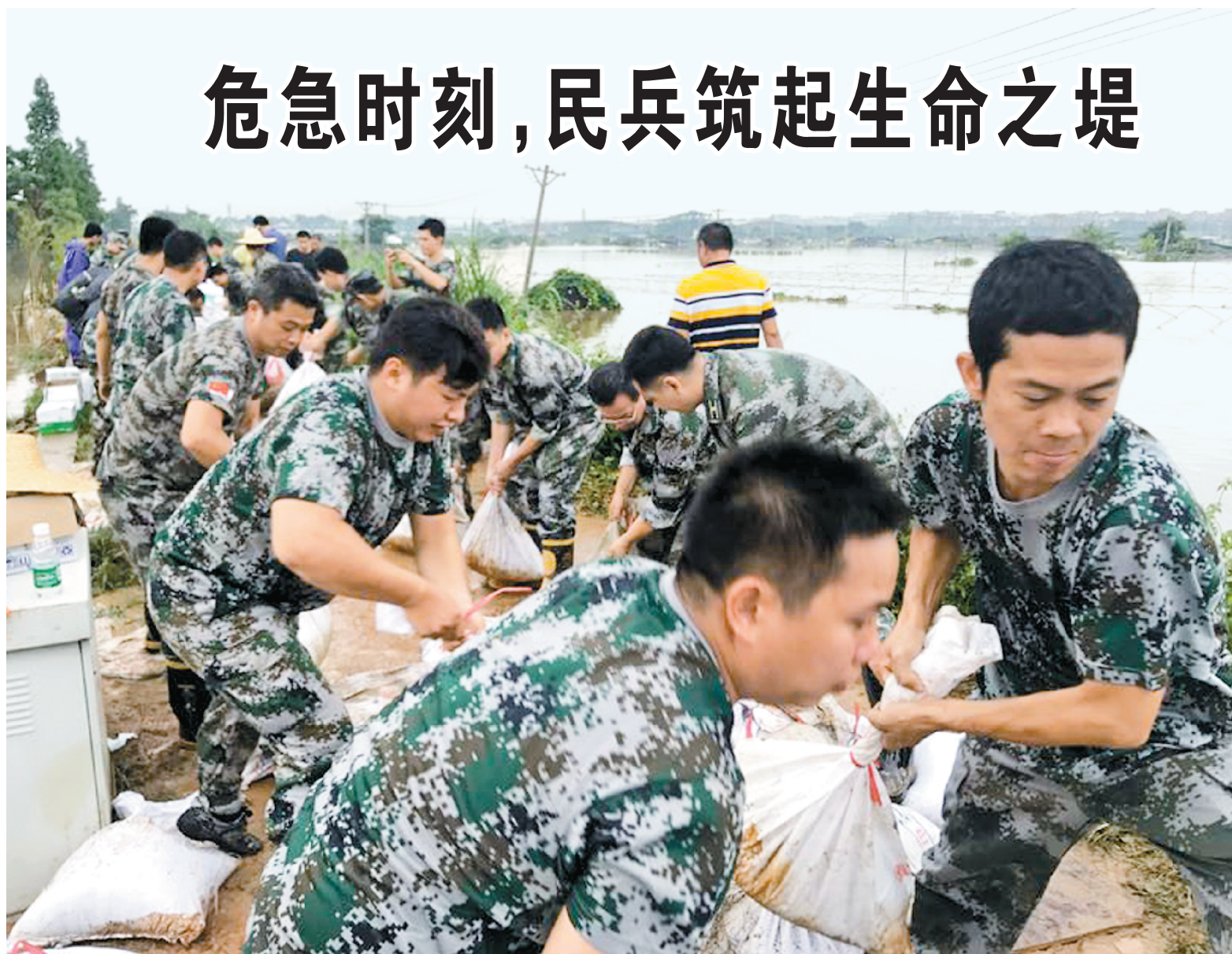
六月八日，受台风“艾云尼”影响，广东省佛山市南海区狮山镇一河涌发生决堤险情，造成约七百亩农田被淹。南海区人武部迅速组织一百六十名民兵奔赴现场抢险救援，共填埋沙袋一万余袋，打桩一百余根，转移受灾群众百余人。截至九日凌晨一时二十分，顺利完成抢险救援任务。
