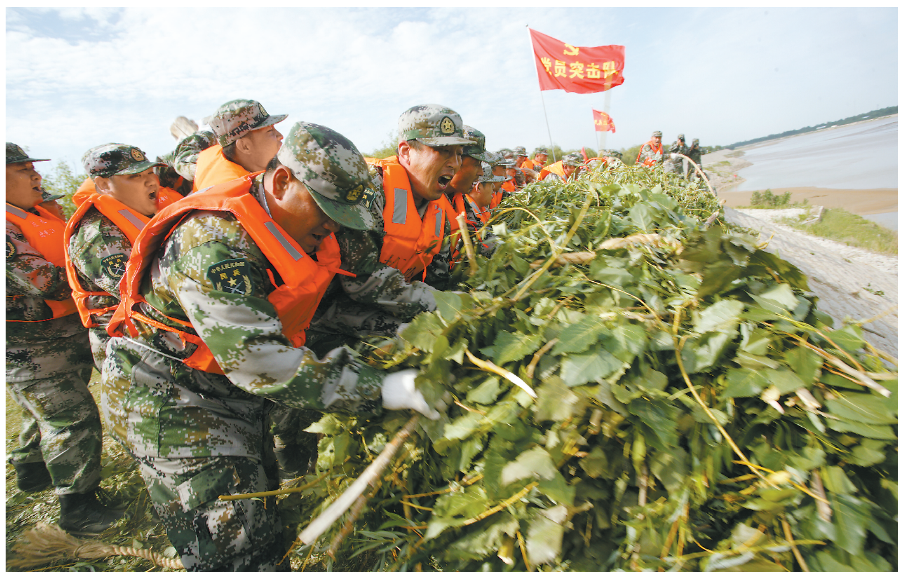
6月12日,山东省德州军地组织民兵防汛应急分队在齐河县黄河滩区进行黄河防汛抢险演练,进一步摸清黄河德州段汛情变化特点规律,完善应急处置预案。图为民兵在捆扎柳石枕。
