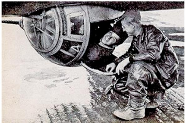
B-17轰炸机的机腹球形机舱塔。
