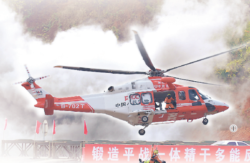
图①:空地联动救援。图②:铺设硬质路面。图③:疏导被困群众。图④:架设模块化桥。图⑤:架设公路钢桥。
