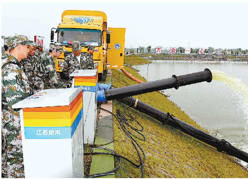
6月18日，江苏省抗洪抢险中心，仅征民兵抗洪抢险连与扬州水利、应急管理单位的165名军地抗洪抢险骨干进行封闭集训，接受包括冲锋舟驾驶、抽水泵操作、钢木土石坝构筑等技能培训，以应对汛期可能出现的洪涝灾害。周晓明摄
