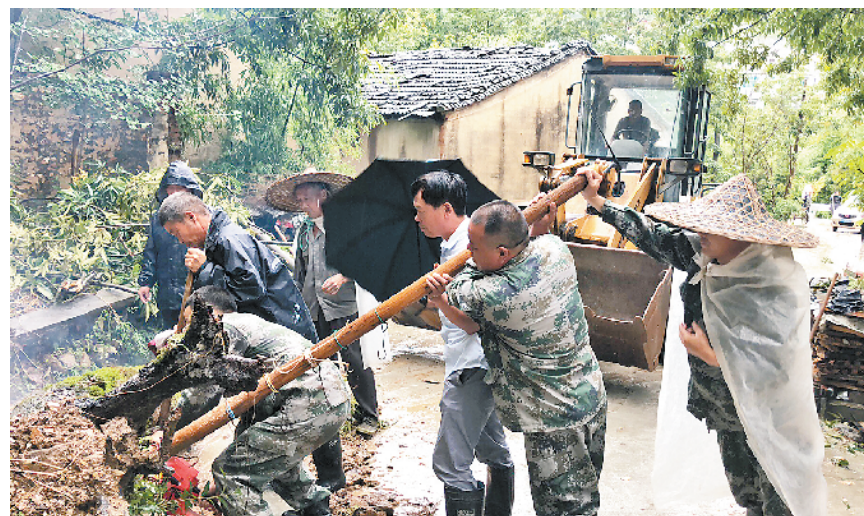
7月12日至13日,浙江省杭州市临安区岛石镇遭遇强降雨,出现道路雨水漫灌、山体滑坡等险情。岛石镇民兵紧急出动抢险救灾、清理路障,确保村民出行安全。图为民兵清理落石树枝,为来往车辆扫除障碍。潘燕飞摄
