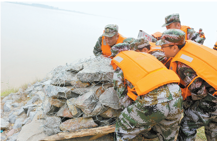
近日，河南省封丘县人武部组织民兵防汛应急分队进行抗洪抢险演练，进一步提升抢险救灾能力。图为民兵正在进行装抛铁丝石笼。
