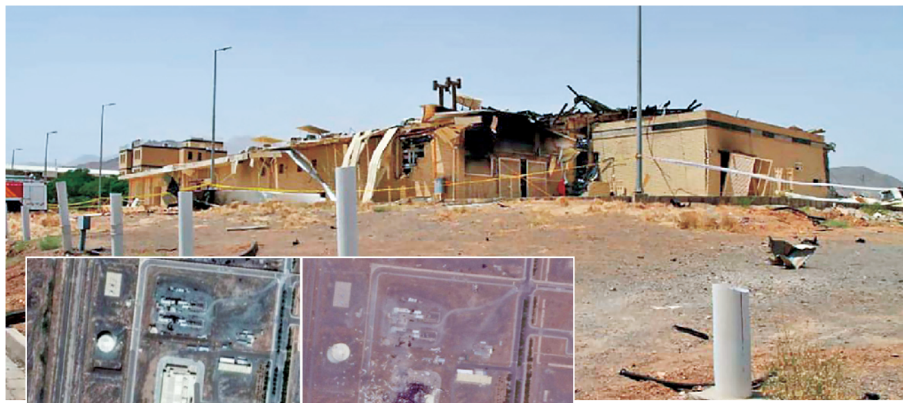
纳坦兹核设施被大火烧毁后的建筑物
