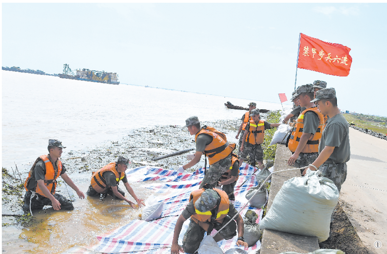
图①:7月12日,陆军第72集团军某旅官兵在江西省鄱阳县饶河青山圩段执行堤坝加固任务。图为官兵正在铺设防浪布。
