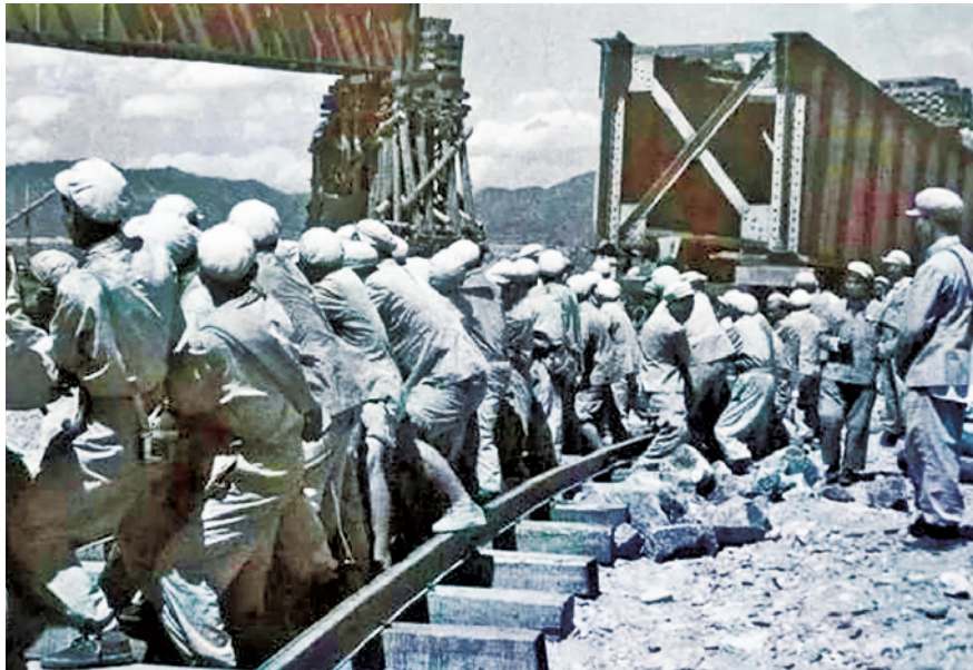
铁道兵冒着敌机轰炸架起被炸塌的钢梁
