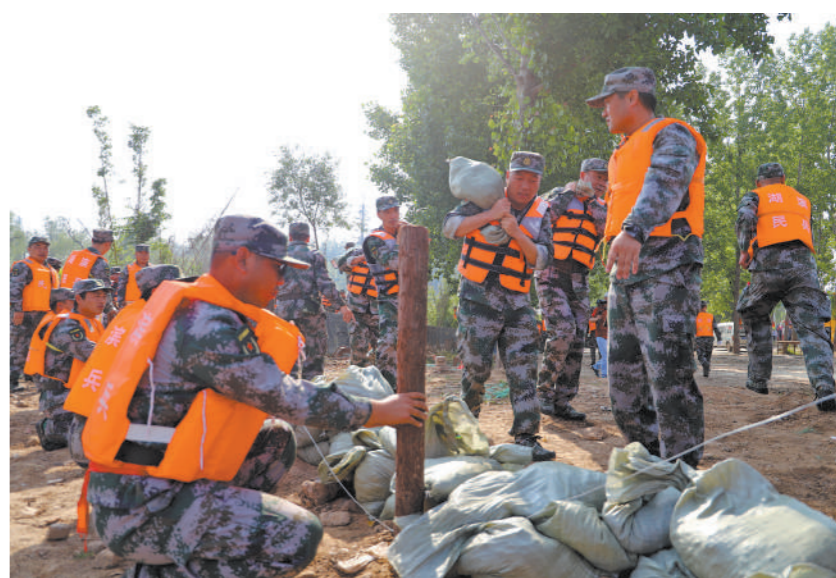
6月上旬，河南省三门峡军分区组织基干民兵在黄河流域进行抗洪抢险演练。图为应急分队通过植木桩、垒沙袋的方式筑坝。凡军亚摄
