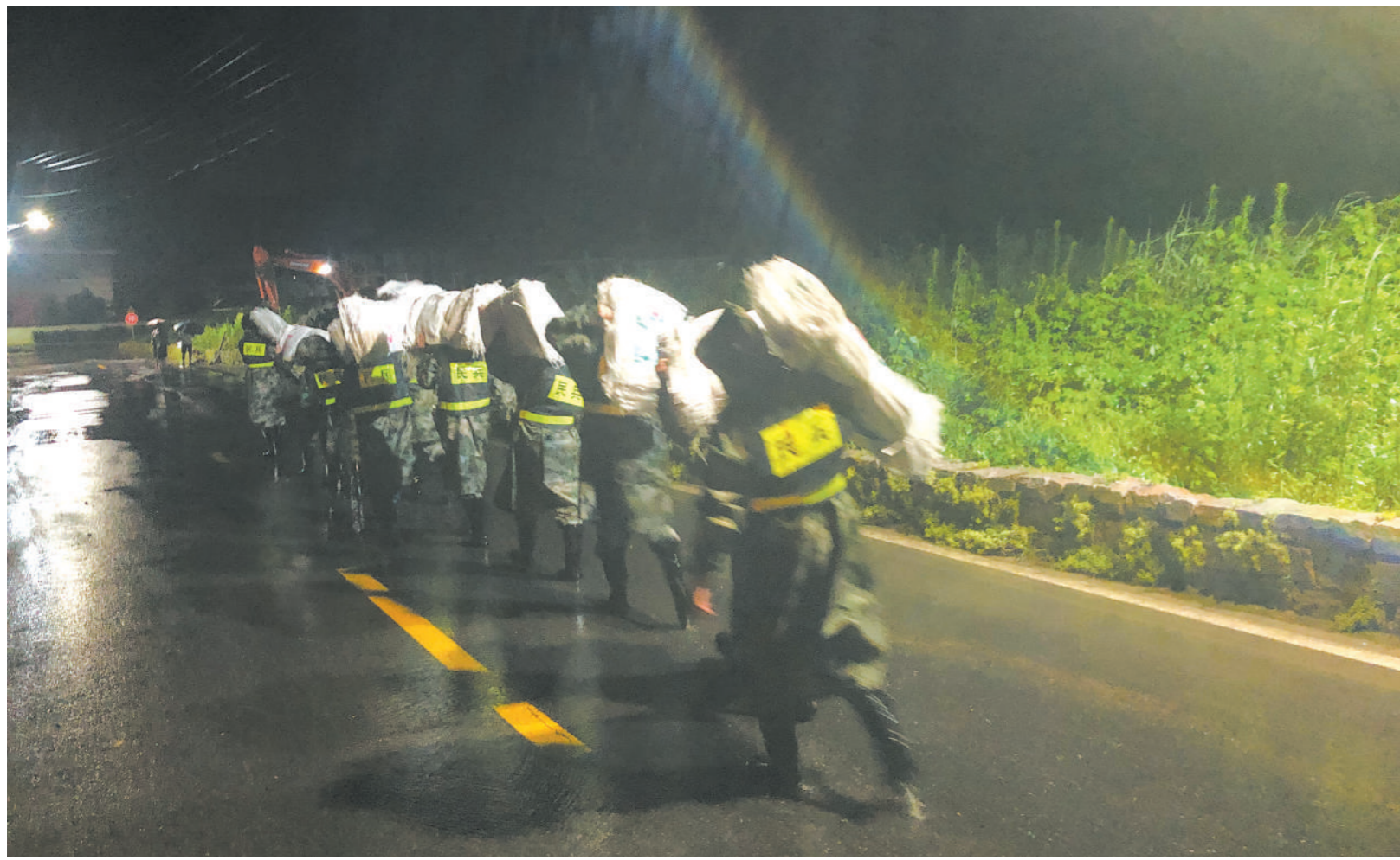
七月二十四日晚,浙江省杭州市萧山区河上镇永兴河水位超过警戒线。该军区武部迅速组织城厢街道民兵连夜赶赴河上镇加固堤坝。姜永华摄
