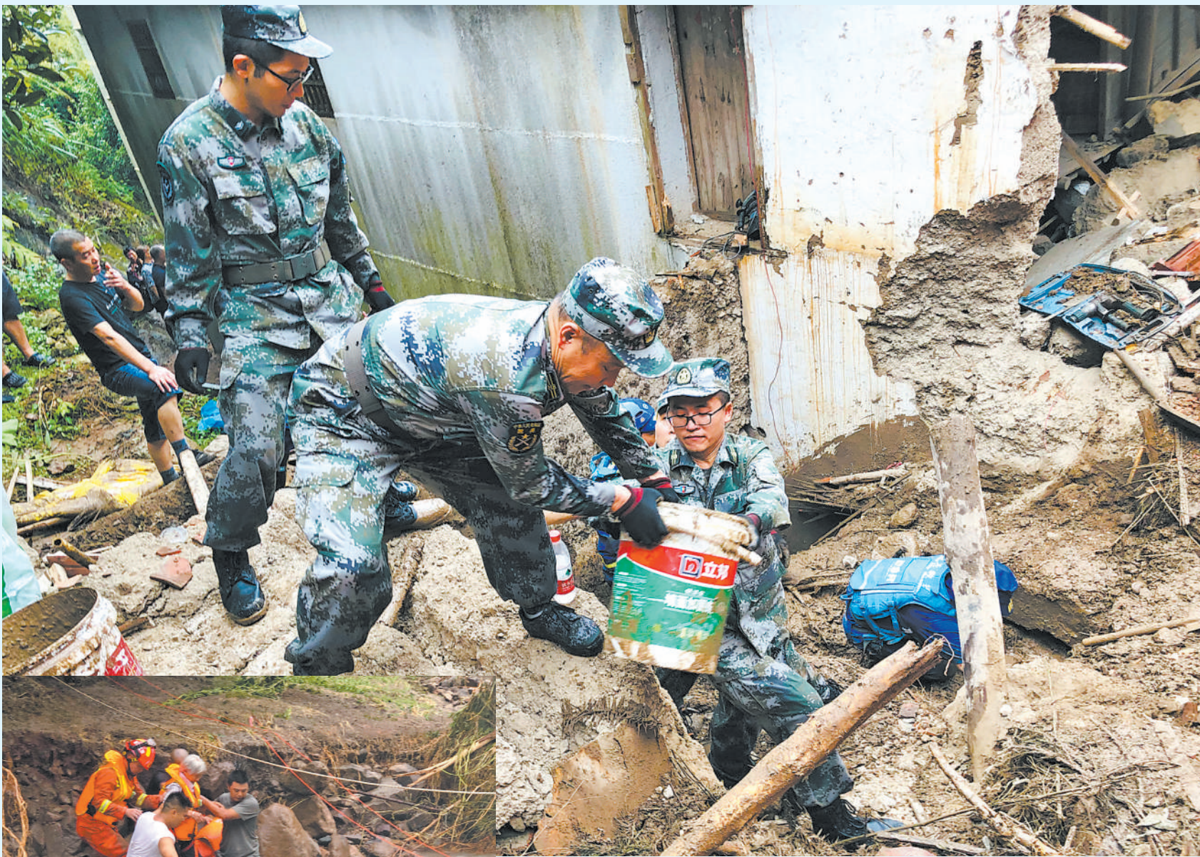
9月6日，浙江省金华市婺城区南部山区遭遇强降雨，区人武部紧急组织应急连民兵投入救灾救援，清理疏通坍塌道路12处，协助转移受困群众25人。
