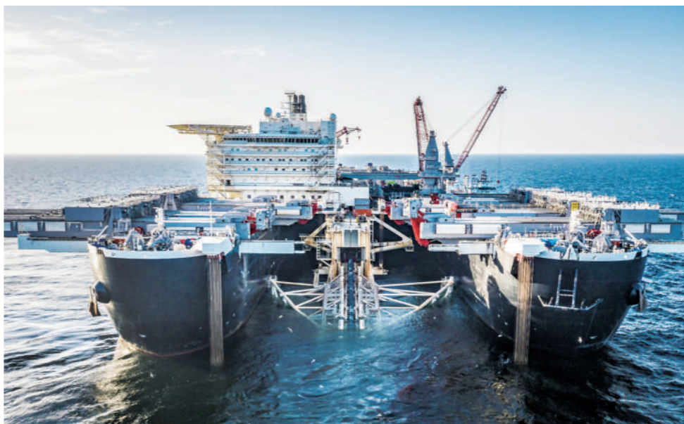
铺管船在铺设海底管道
