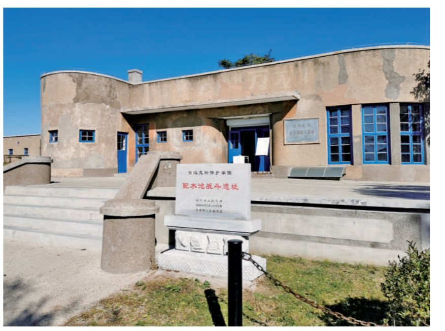
配水池战斗遗址
