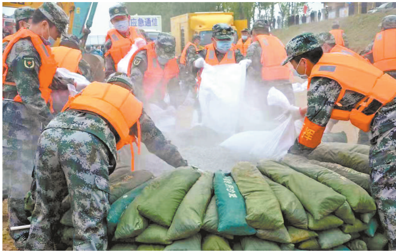
4月15日，河南省上蔡县人武部组织防汛抗洪应急演练。图为民兵应急连进行塌岸抢险课目训练。张延栋摄
