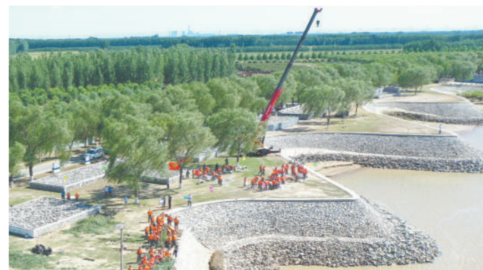
山东省邹平市黄河防汛抢险演练现场,民兵应急队伍分组配合无人机、吊车等装备进行演练。
