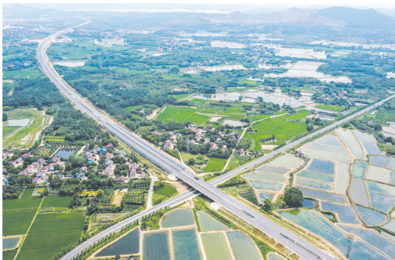
溧阳至宁德高速公路江苏段是国家高速公路的重要组成部分，北接扬溧高速，南接溧宁高速公路安徽段，全线将于年内建成通车。图为7月26日，社渚互通正在加紧施工中。
