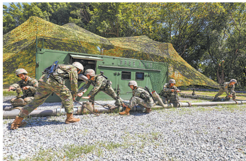
连日来,联防保障部队某团组织输油管线铺设训练,着力提高复杂环境下应急保障能力。图为参训官兵在开设输油泵站。张佳豪摄
