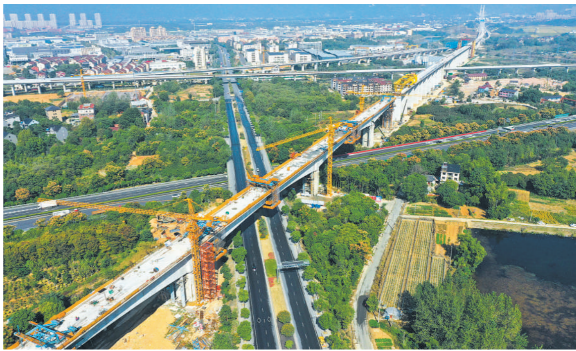
十月二十日，位于浙江杭州桐庐县境内的杭温铁路二期工程跨杭黄铁路特大桥长达三百九十米的连续梁顺利合龙。新华社记者 黄宗治摄
