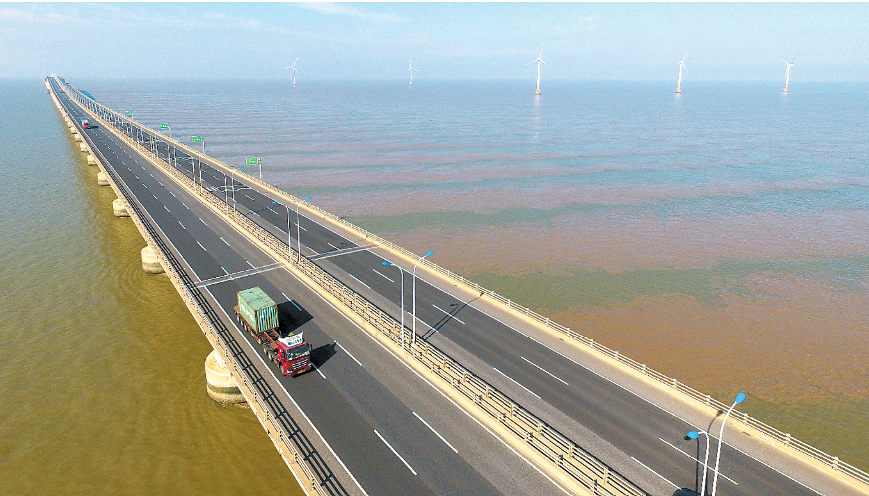
俯瞰上海东海大桥海上风电场 上海市东海大桥海上风电场位于上海浦东新区临港新城至洋山深水港的东海大桥两侧,总装机容量为20.42万千瓦。据悉,东海大桥海上风电示范项目自投入运营以来,总计上网电量约22亿千瓦时,节约标煤70.6万吨,减少二氧化碳排放195万吨。图为俯瞰上海东海大桥海上风电场。 新华社发
