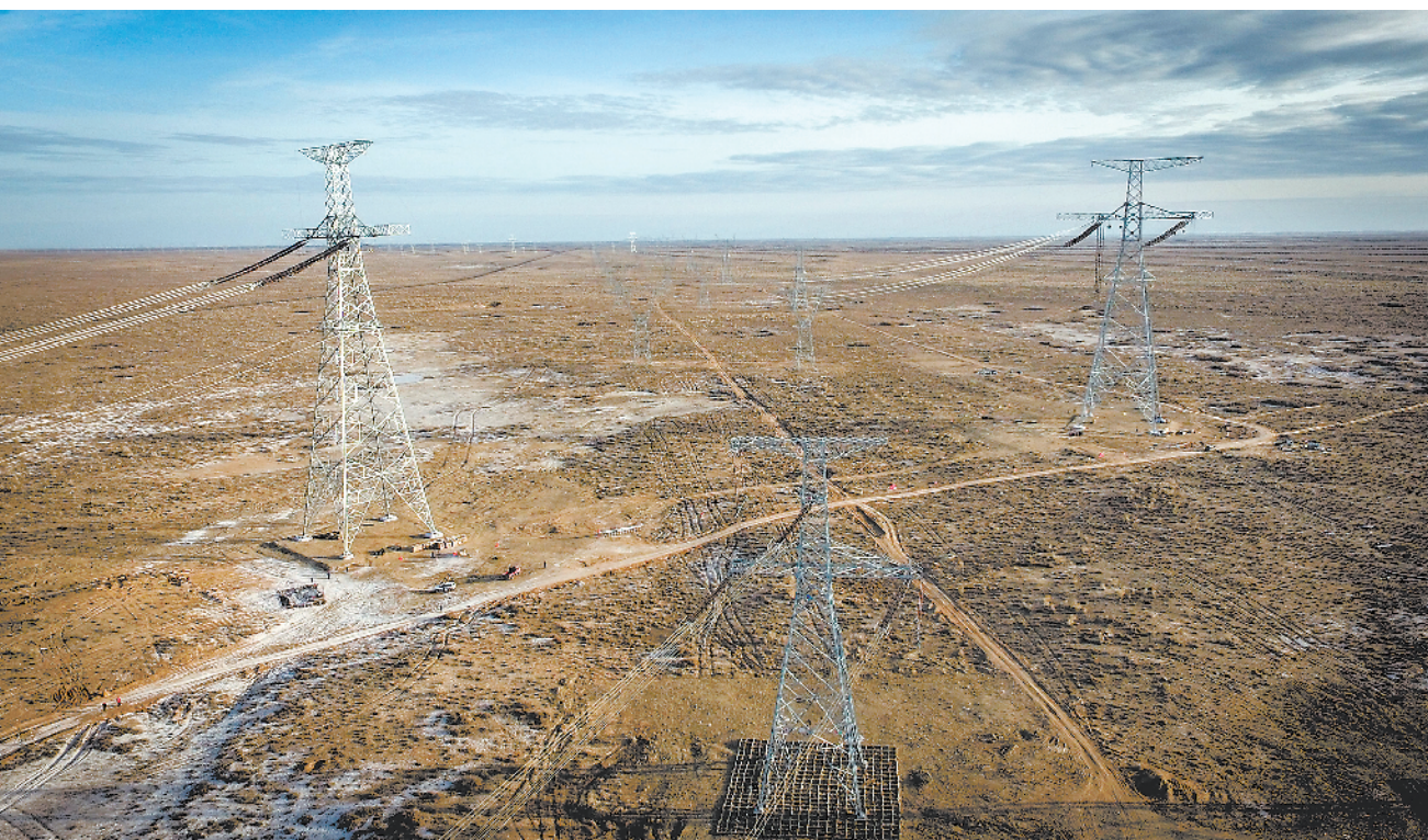
3月29日,全长598.684千米的准东——皖南±1100千伏特高压输电工程新疆段全线贯通,为我国进一步打造以特高压为骨干的智能电网提供了支撑,促进了西部可再生能源利用,也为能源大区新疆推进“疆电外送”提供了又一条空中大通道。图为从空中俯瞰准东——皖南±1100千伏特高压输电工程跨越750千伏电网施工现场。
