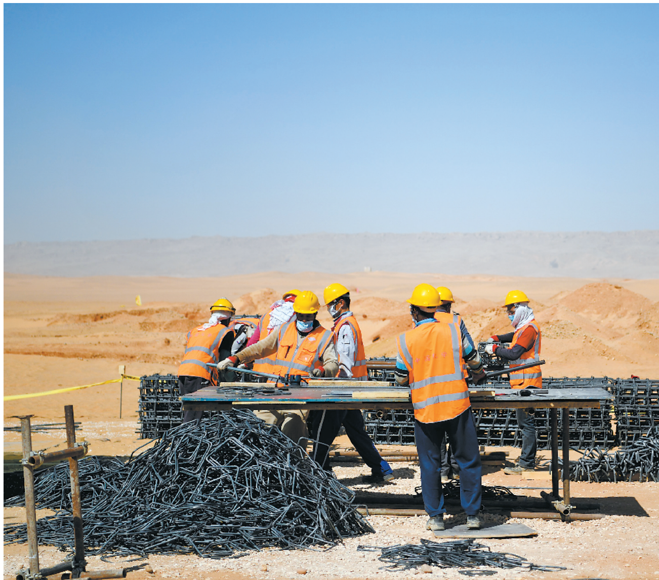
4月10日,在埃及南部阿斯旺省本班光伏产业园,工人在首个由中国企业承建并参与融资的光伏发电项目施工现场工作。该光伏发电项目装机容量1.86兆瓦,当天在本班举行奠基仪式。新华社发
