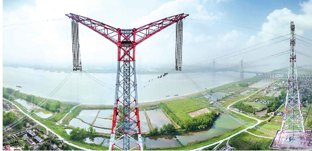
4月15日上午,位于安徽省无为县高沟镇的±1100千伏吉泉长江大跨越架线北岸张力场正在紧张施工。图为导线展放后的昌吉特高压长江大跨越工程北岸跨越塔。
