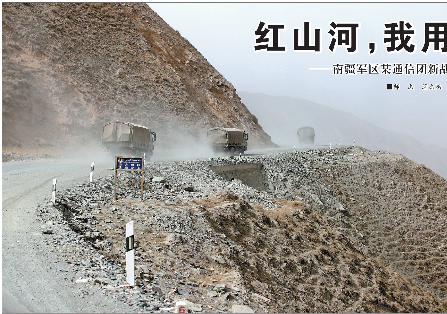
车队快速通过塌方路段。
