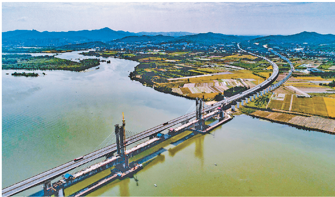
经过3年建设,由中铁十一局集团承建的蒙华铁路汉江特大桥主跨合龙在即(5月7日航拍)。蒙华铁路汉江特大桥位于湖北省襄阳市区上游约3公里的汉江上,总长5242米,是蒙华铁路重点控制性工程之一。蒙华铁路是国家《中长期铁路网规划》的重大项目,北起内蒙古鄂尔多斯,南至江西吉安,规划年运输能力超过2亿吨。
