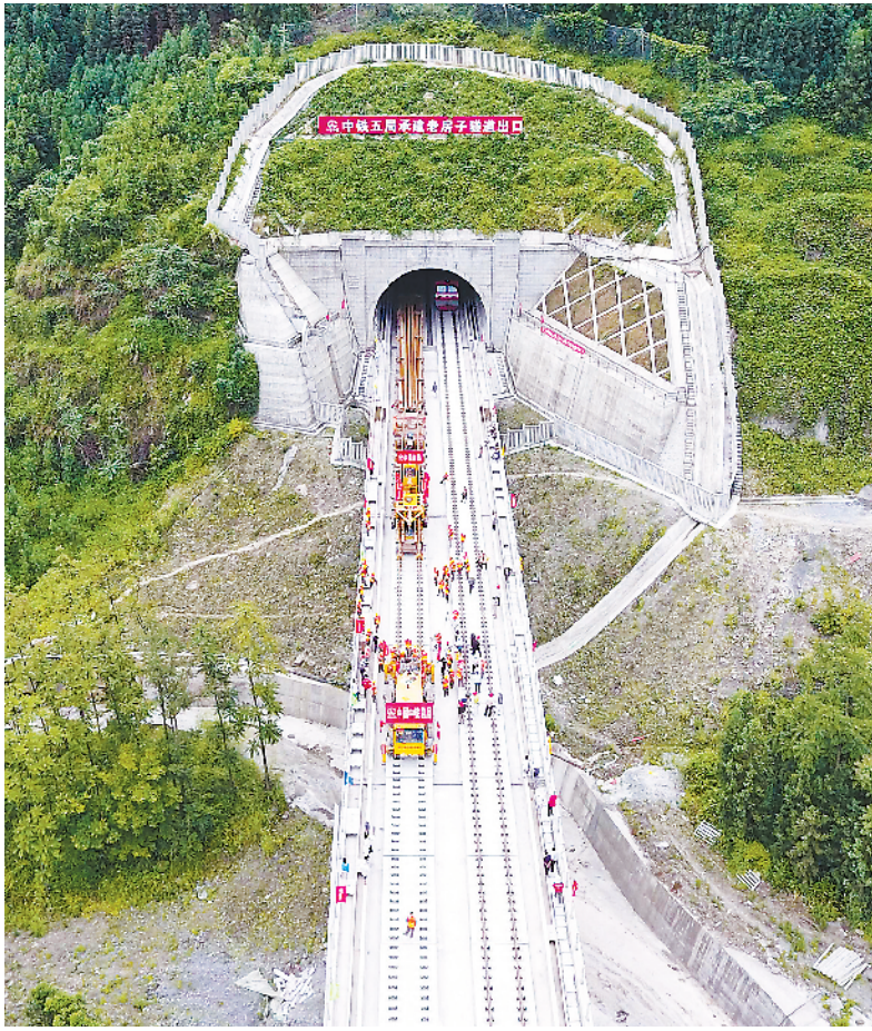
5月30日,成(都)贵(阳)铁路四川段正线最后一对钢轨在四川省宜宾市兴文县境内顺利落下,标志着成贵铁路四川段正线铺轨任务圆满完成。 新华社发
