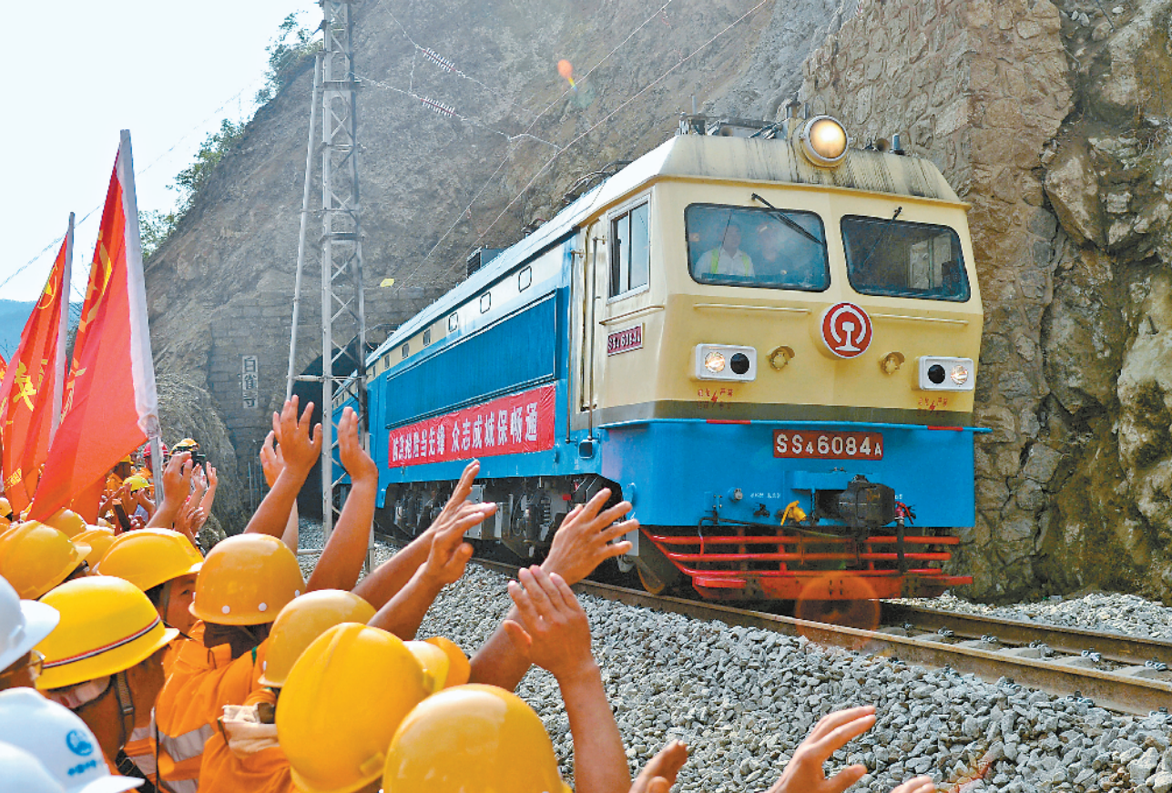
7月28日17时，中断行车16天的宝成铁路顺利抢通，全线恢复通车。图为当日，列车通过抢通的宝成铁路王家沱至乐素河区间。
