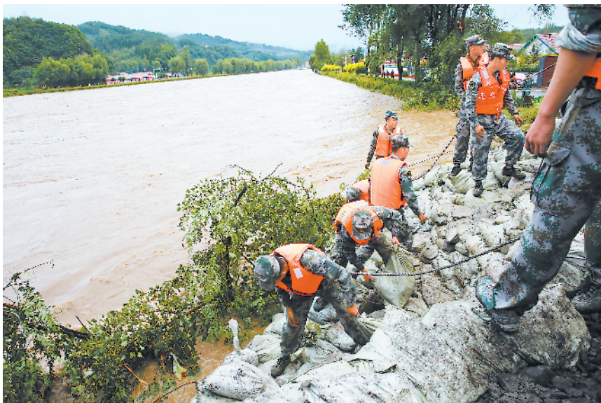
8月24日,吉林省东部浑江水域多段出现险情,第78集团军某旅出动300余名官兵奋战在抗洪抢险第一线。图为官兵对河堤进行加固。丁柏松摄
