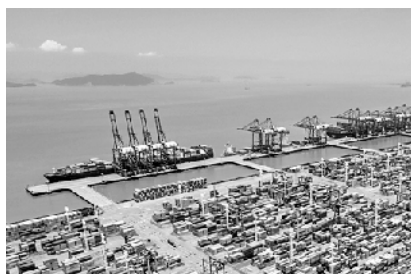
宁波舟山港穿山港区码头
