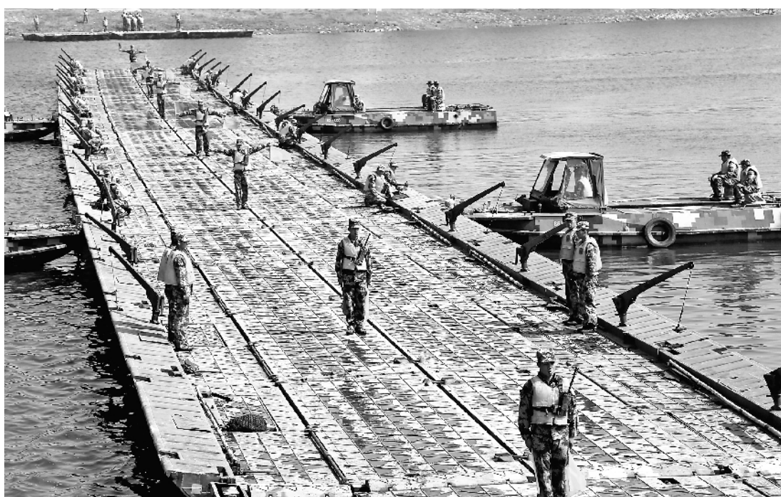
第八十一集团军某旅严格落实新大纲要求,近日在驻地附近水域开展开浮桥架设训练,全面提高舟桥专业快速反应能力。图为舟桥分队严格按照操作规程架设浮桥。 张旭摄
