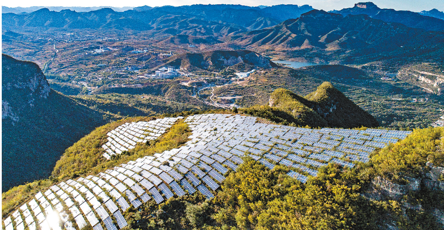
近年来，河北省武安市加快发展清洁能源，利用太行山区光能资源优势，推进山地光伏发电基地建设，壮大绿色经济。图为10月7日拍摄的河北省武安市贺进镇贺进村光伏发电项目。新华社发
