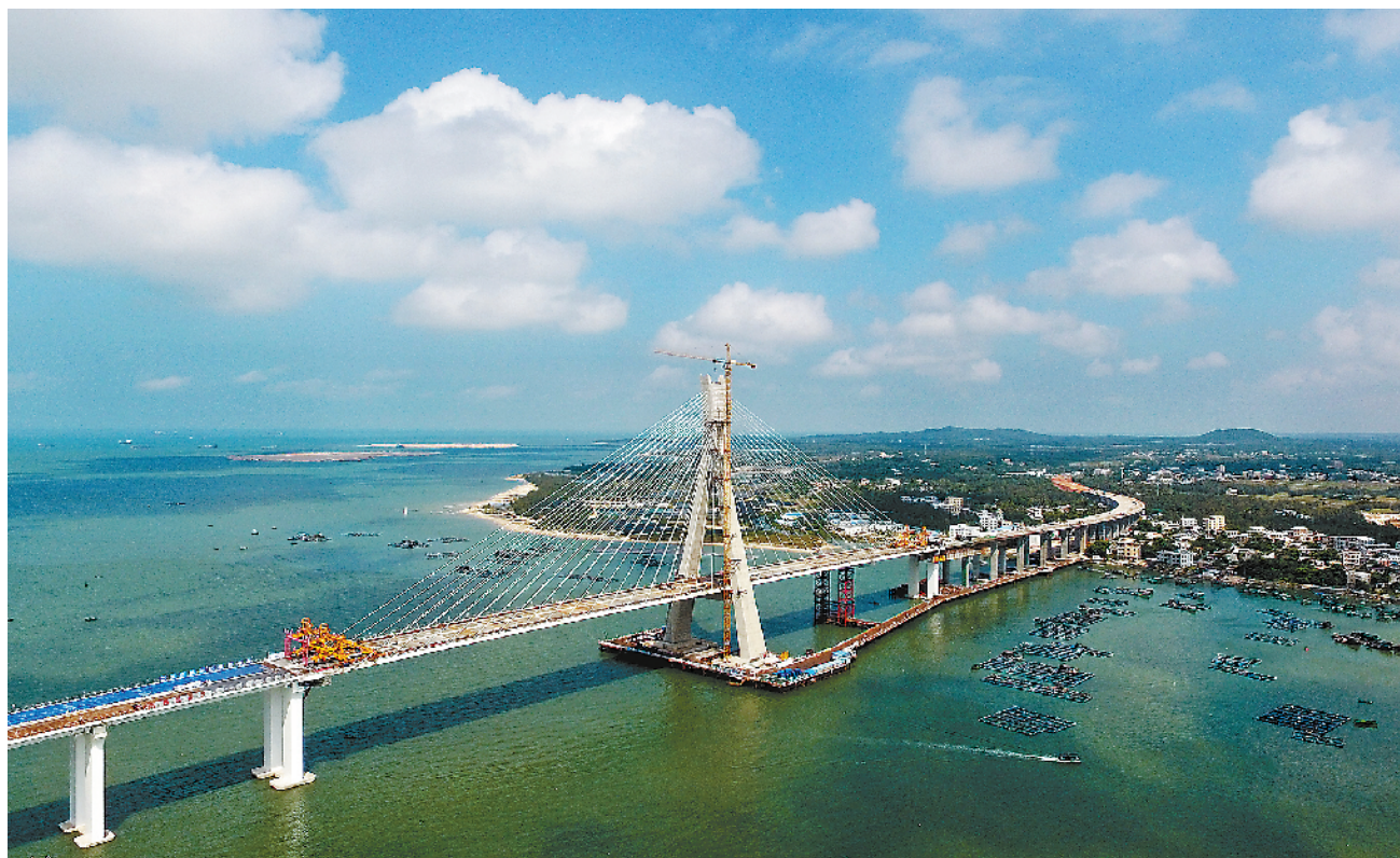
11月3日，中国首座跨越地震活动断层的跨海桥梁——海南铺前大桥主桥顺利合龙。
