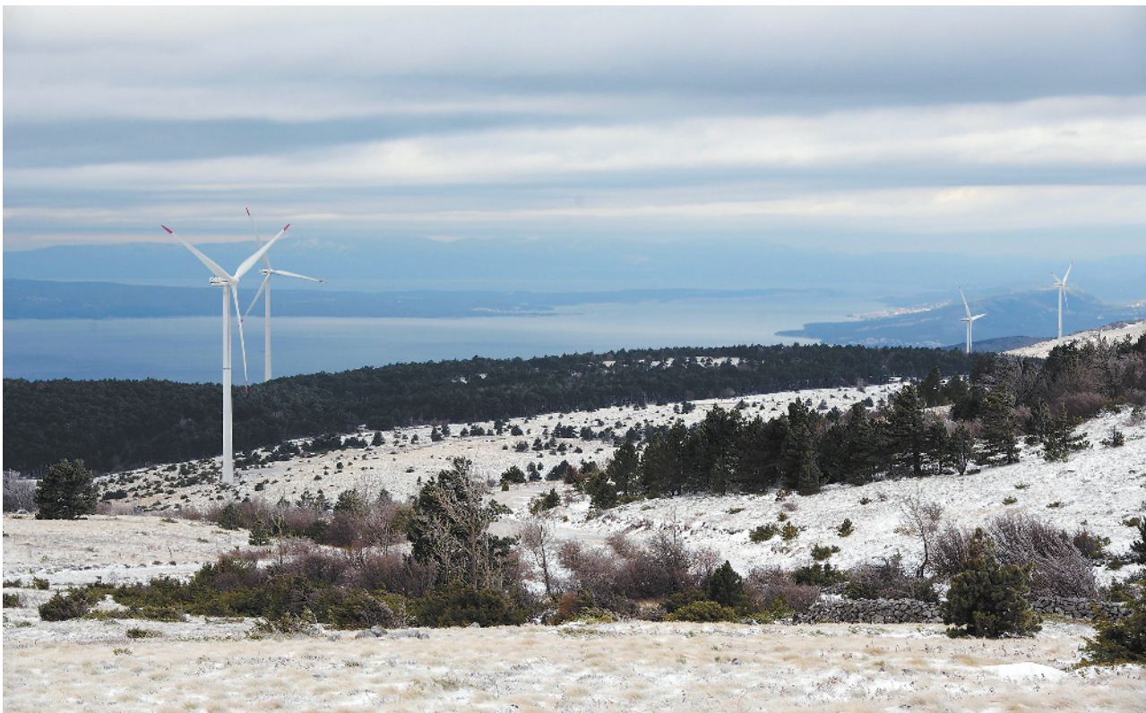
中国企业投资的克罗地亚塞尼风电项目11月20日开工。塞尼风电项目总装机156兆瓦，建成后预计年均发电3400小时，年发电量5.3亿度。项目总投资达1.79亿欧元，计划2年安装完成。图为塞尼风电场。
