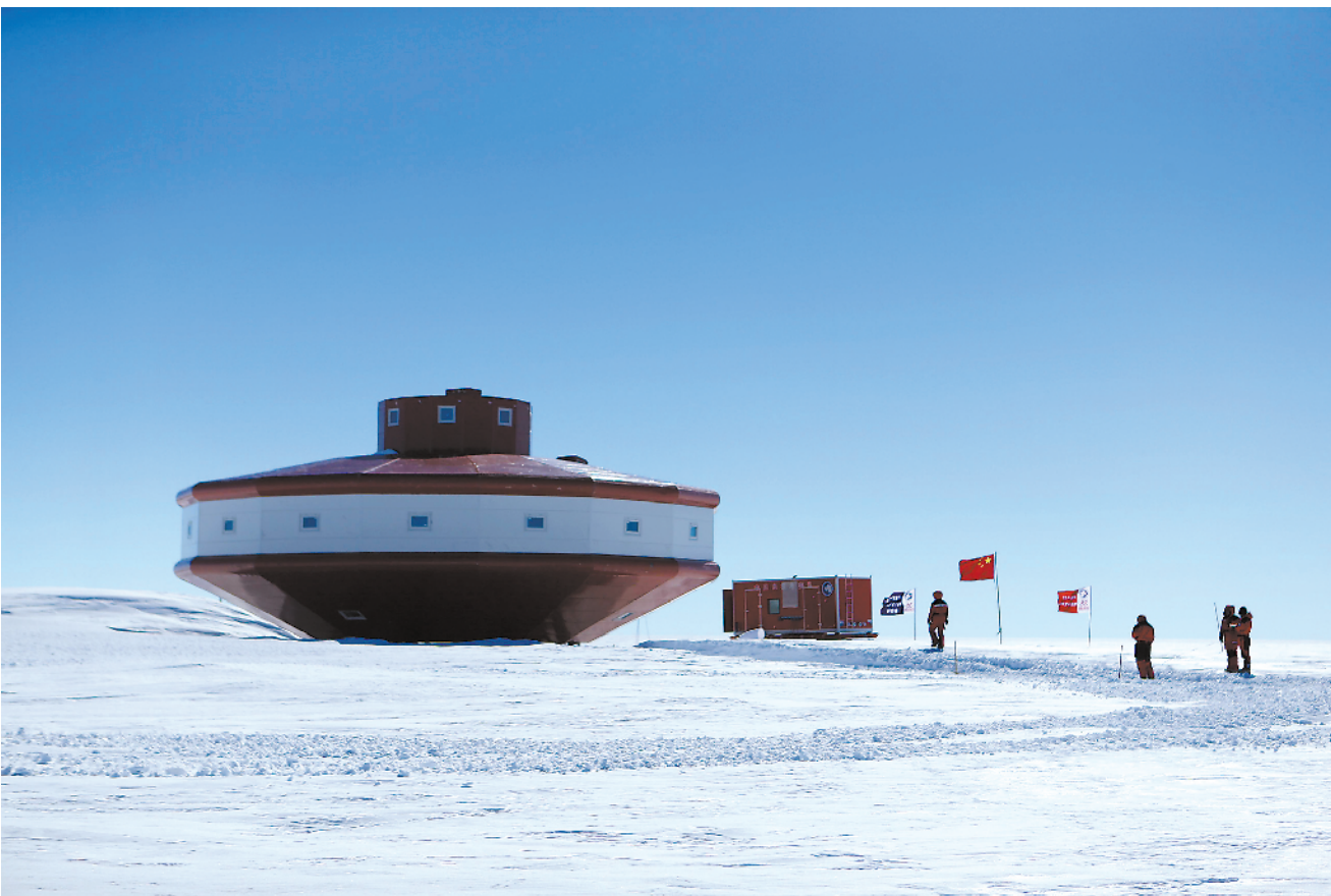
12月26日，中国南极泰山站二期工程正式开工，主要任务是完成泰山站配套系统工程。图为泰山队队员进行泰山站二期工程定位放线。
