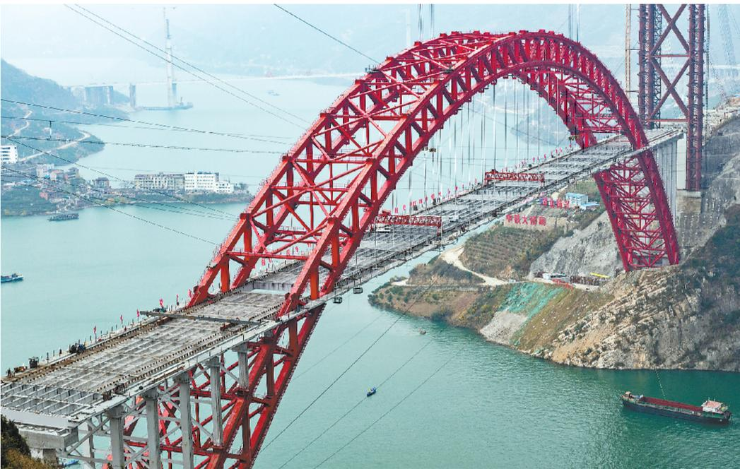
12月27日,随着最后一跨钢主梁成功吊装就位,位于湖北宜昌的香溪长江公路大桥主桥顺利合龙,标志着这座世界最大跨度钢箱桁架推力式拱桥开始进入桥面铺装施工阶段。图为香溪长江大桥主桥合龙施工现场。新华社发
