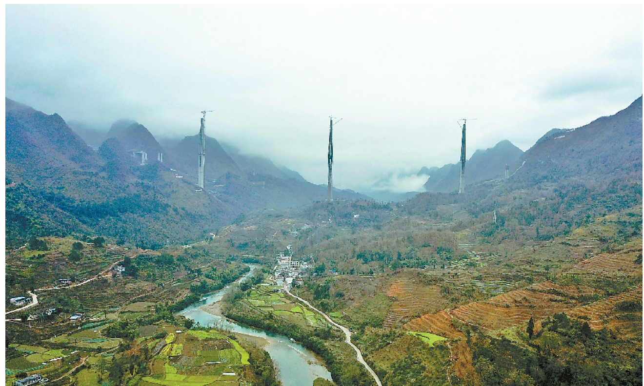
平塘特大桥横跨贵州平塘县通山镇平里河村渡渡河谷,其中16号塔已于2018年11月成功封顶,成高332米。目前该桥工程已进入钢梁安装阶段,预计于2019年底完工。图为1月7日无人机航拍的桥塔全景,中为高332米的世界第一高混凝土桥塔。
