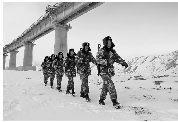
徒步巡逻。昆仑山隧道守护中队官兵在铁路沿线。史彦斌摄
