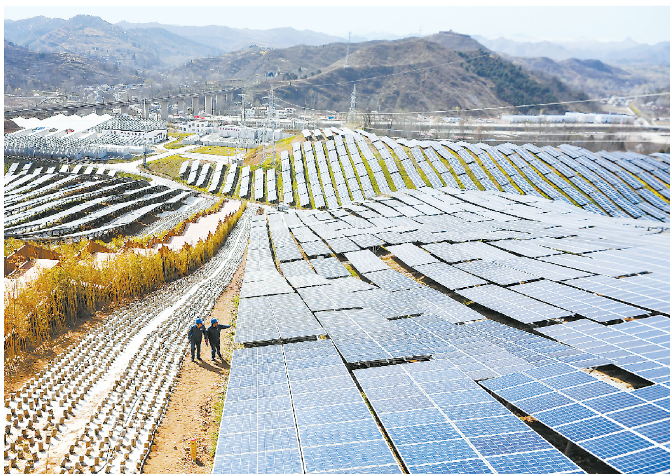
近年来,陕西省商洛市商州区利用当地荒山荒坡和相对充足的光照条件,以“光伏+”为发展模式,建立“农光互补”型集中式光伏电站,上方光伏板发电,光伏板下兼顾农业生产,实现“一地两用”,带动贫困户增收。图为电力工人在陕西省商洛市商州区龙山光伏电站巡视(3月29日摄)。
