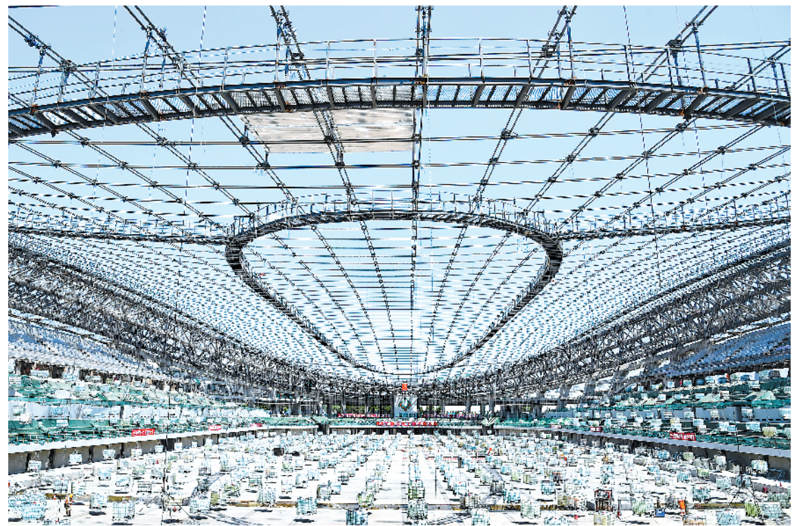
2022年北京冬奥会5月10日迎来倒计时1000天，各项筹办工作正在稳步推进，场馆基础设施建设、测试赛筹办进展顺利。图为国家速滑馆施工现场。新华社发
