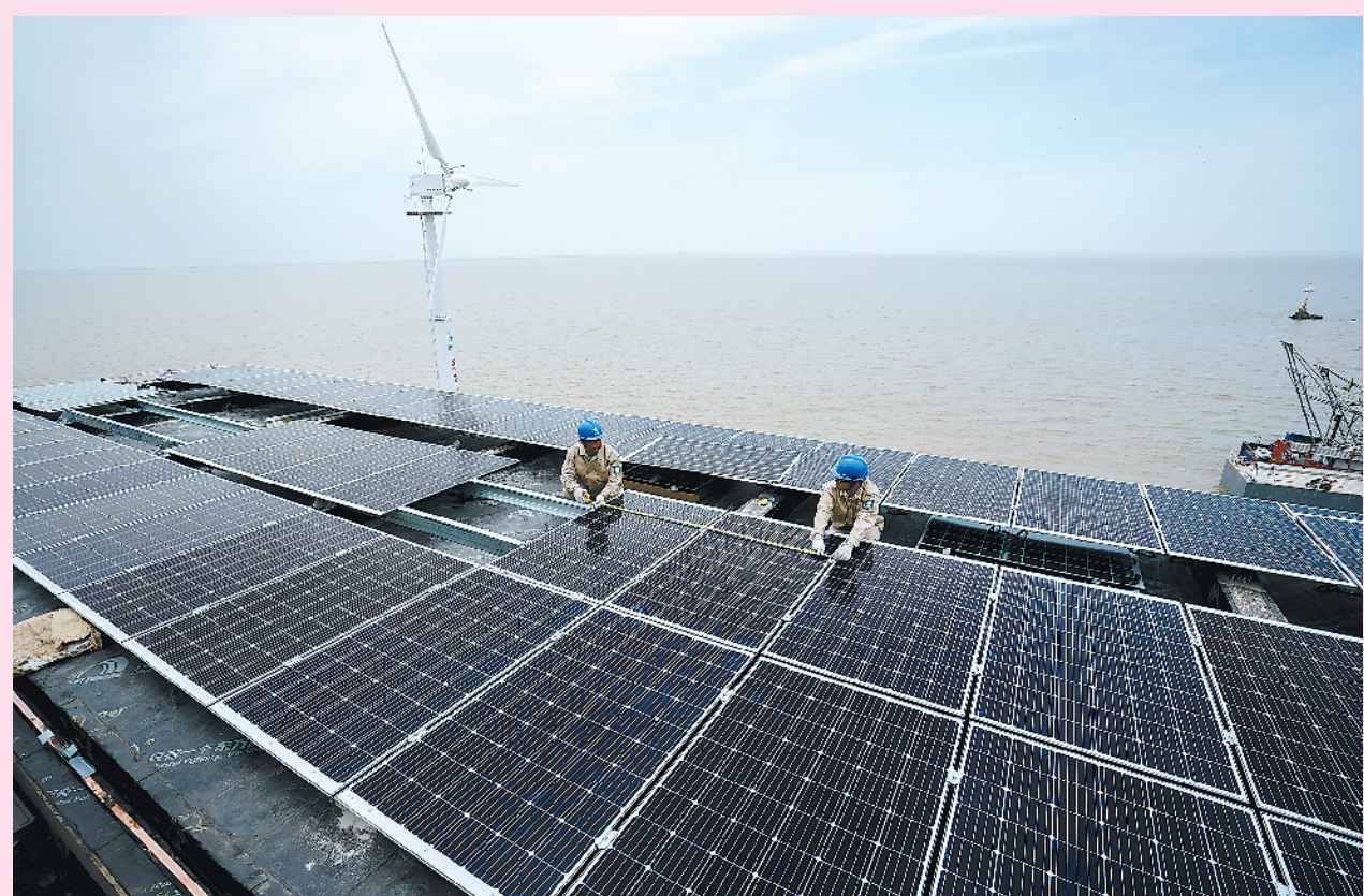
目前,江苏省正加快开山岛微电网二期工程建设,岛上将建起由30千瓦风机、120千瓦光伏发电设备以及600千瓦储能设备组成的“风光储互补智能微电网系统”。据悉,该工程将于今年6月正式建成投运,届时,配合新建的一套日产10吨淡水的海水淡化系统,开山岛守岛民兵及上岛参观学习人员的日常用水难题有望得到彻底解决。
