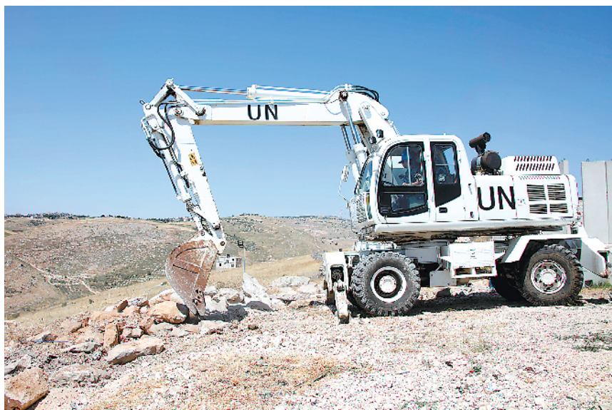
当地时间6月10日,我第十八批赴黎巴嫩维和建筑工兵分队,在黎以边境“蓝线”附近展开部署后的首个工程施工任务。此次任务主要是为尼泊尔营区构建长50米的墙体,以提高其应对各种突发情况的能力。图为操作手操作机械对场地进行平整夯实。 彭 希 摄
