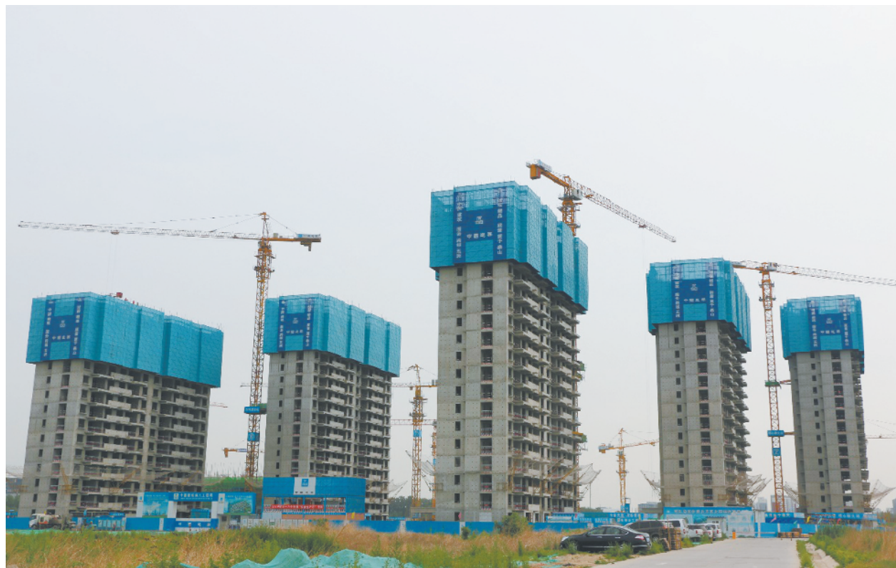
图为北京某统建项目施工现场。
