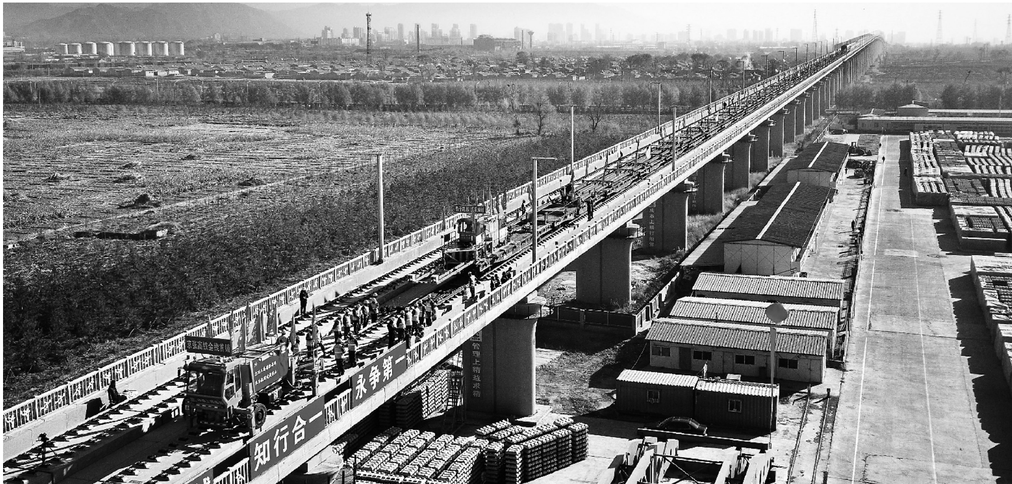
这是铁路工人在京张高铁河北怀来段铺轨现场工作。
