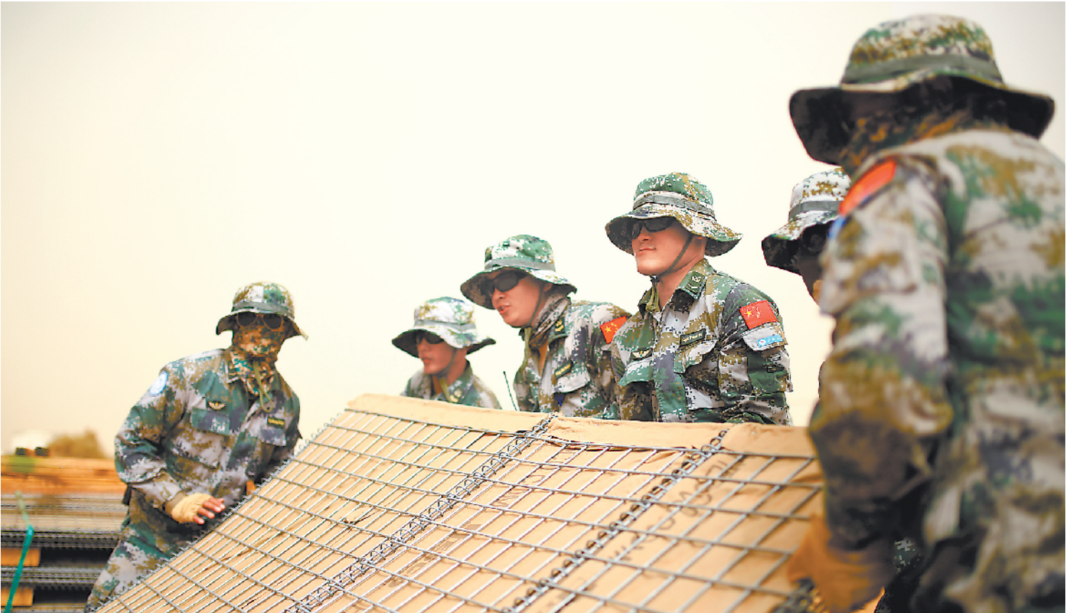
连日来，马里安全形势日益严峻，为防范恐怖分子对机场等重点目标实施袭击，中国第7批赴马里维和工兵分队在加奥机场构筑了数百米的防爆沙箱。图为分队官兵冒着高温酷暑，争分夺秒搭建高层防爆沙箱。 高 嵩 摄
