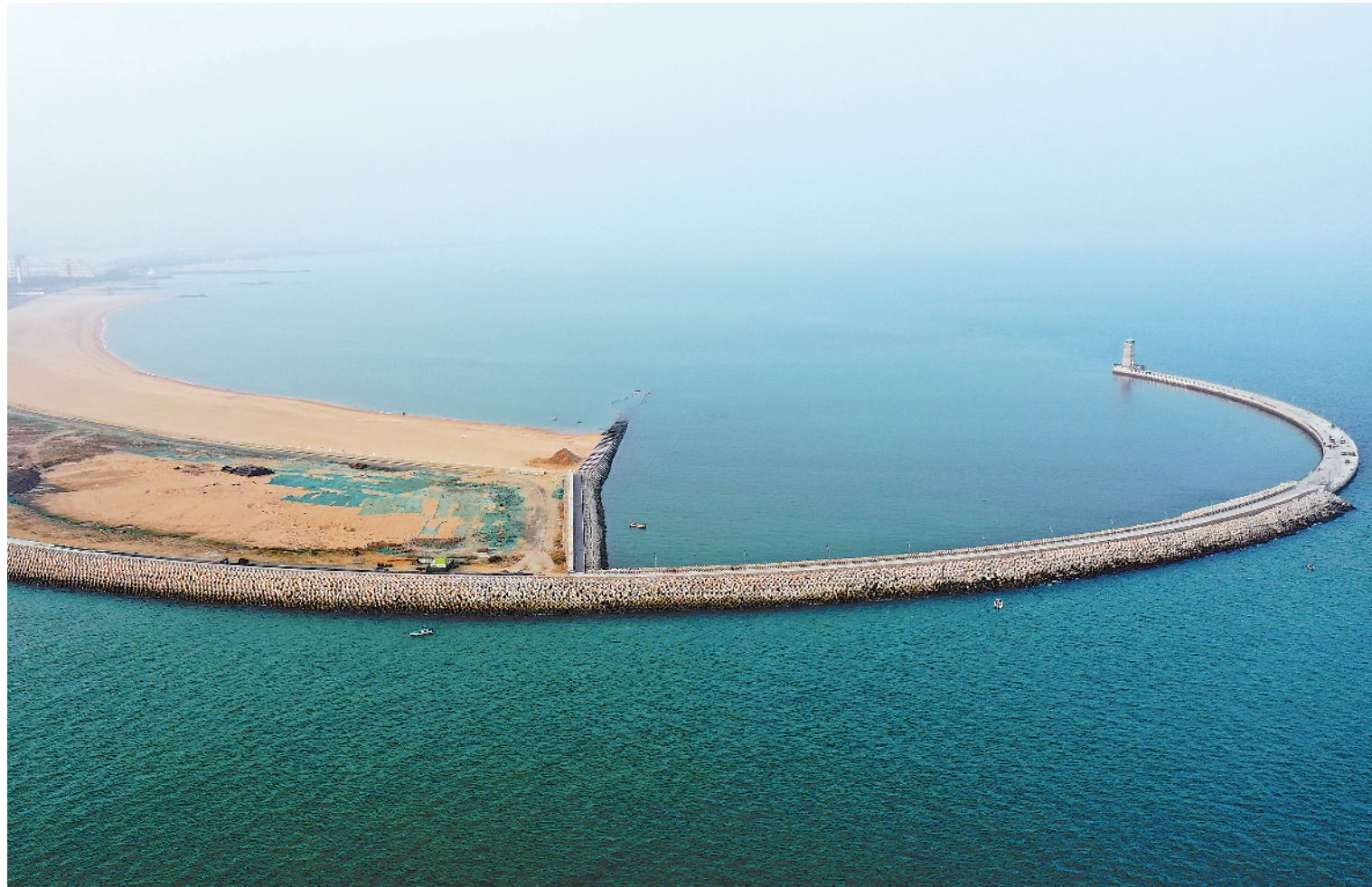
作为全国首个港口工业岸线退港还海、修复整治生态旅游岸线的典型案例，山东日照港石臼港区对港口工业岸线退港还海，使生态旅游岸线自然串联。图为日照港退港还海项目部分区域(10月23日无人机拍摄)。新华社发
