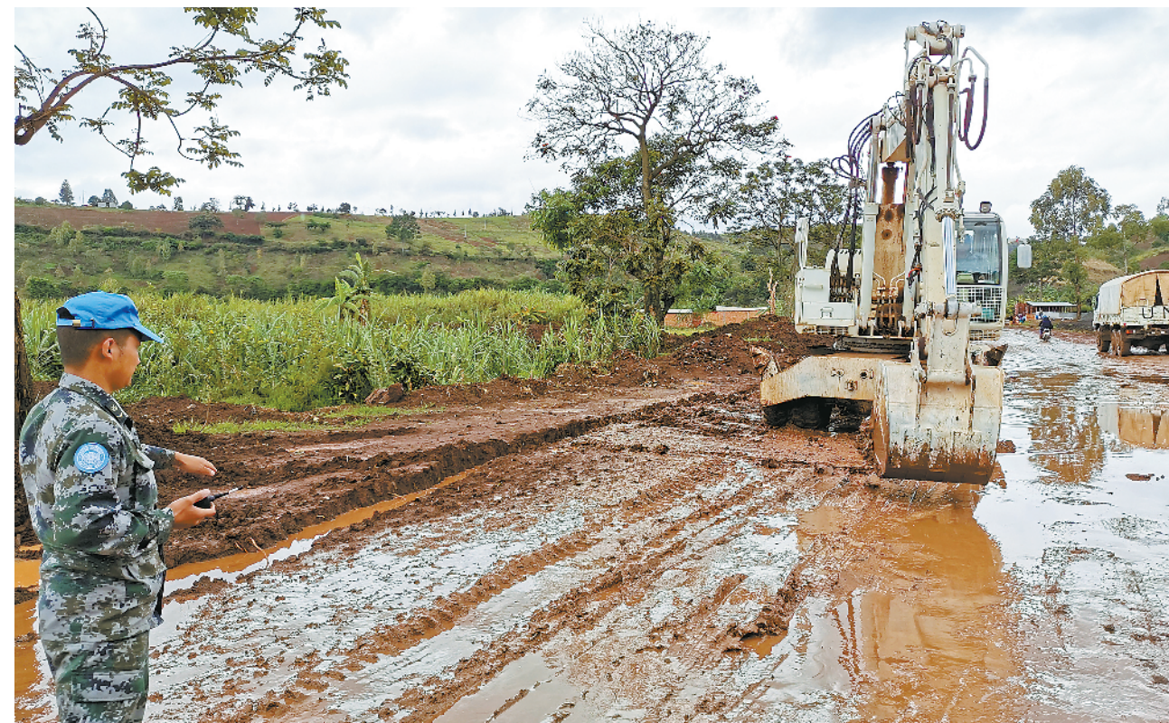
近日，中国第23批赴刚果(金)维和工兵分队完成对布卡武至卡卡姆路段的道路修复。料场附近道路泥泞，且距离施工点最远约20公里，加之雨季来临，大大增加了施工难度。分队官兵克服各种困难，仅用10天就顺利修复道路。图为分队官兵正在清除路面淤泥。 王玺摄
