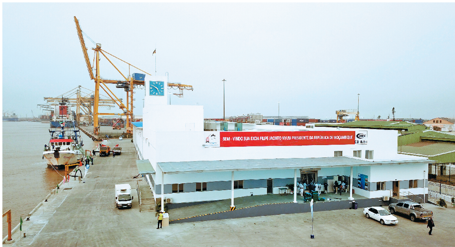
由中国进出口银行贷款融资、中国港湾公司承建的莫桑比克贝拉渔码头修复项目28日正式移交当地政府。莫桑比克总统纽西表示,这是两国政府和人民之间友好关系的又一成果。图为10月28日拍摄的贝拉渔码头冷库。新华社发
