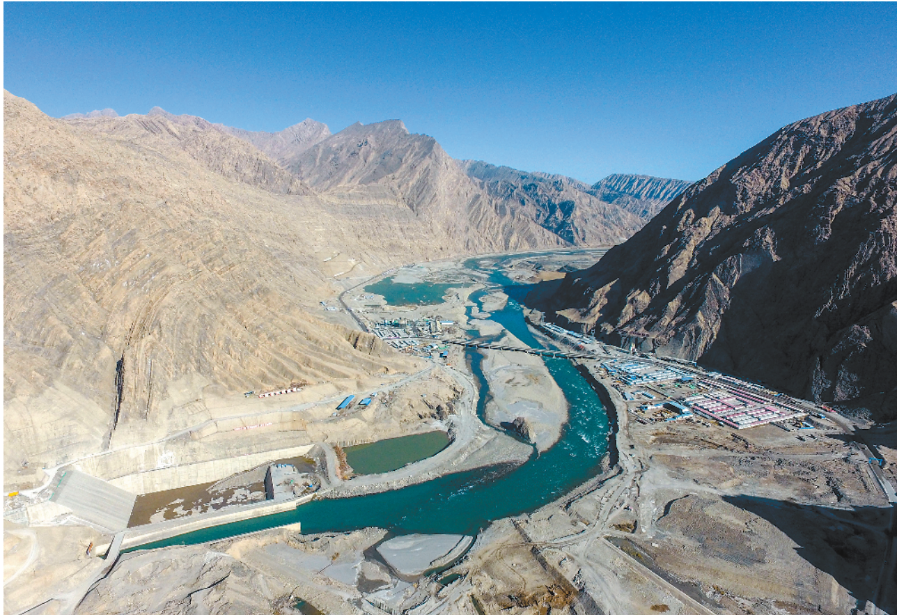
11月19日,新疆重大民生工程——叶尔羌河阿塔什水利枢纽工程水库大坝下闸蓄水。矗立于喀喇昆仑山河谷的大坝将抵挡波涛汹涌的洪水,使叶尔羌河流域彻底告别千年水患。 新华社发
