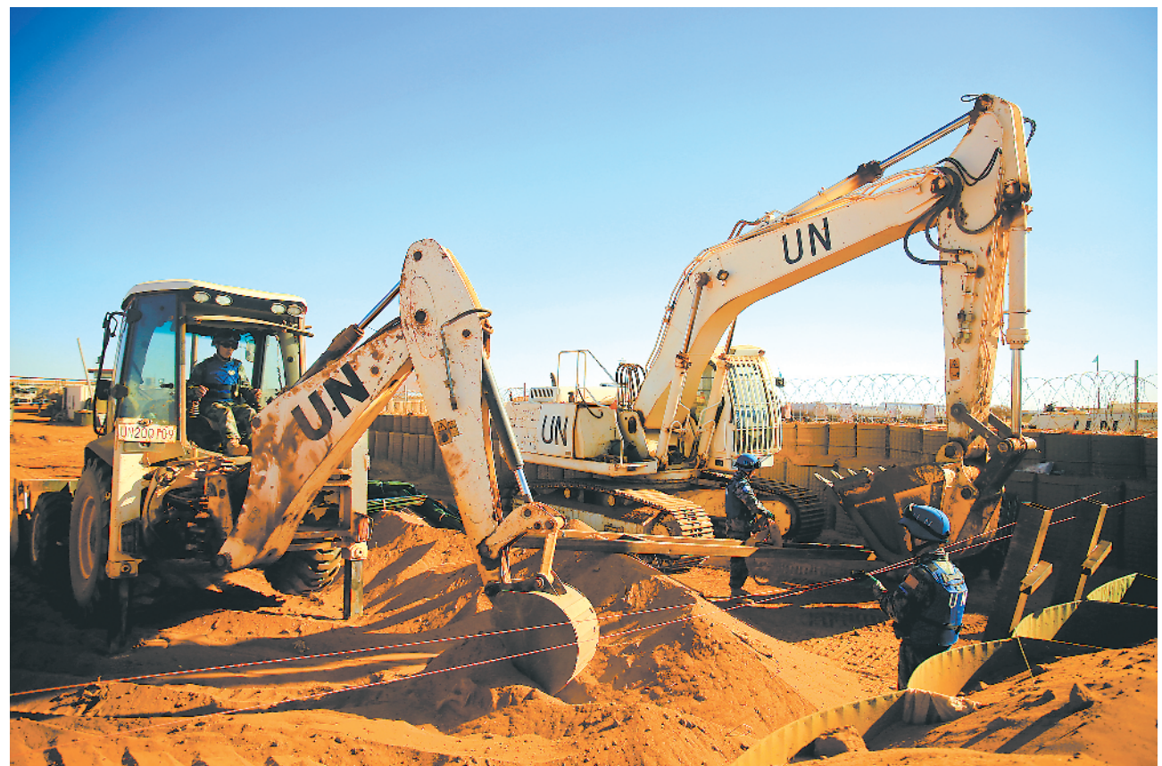
连日来,应联马团民事部门请求,中国第7批赴马维和工兵分队派出兵力,帮助加奥机场修建出入口安防设施,以应对汽车炸弹等恐怖袭击。图为维和官兵11月27日在机场施工。 本报特约记者 高嵩摄
